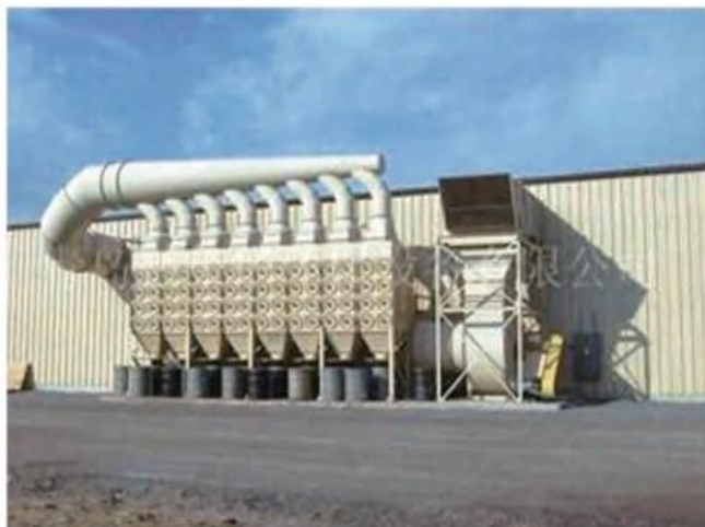
脉冲反吹滤筒式除尘器
